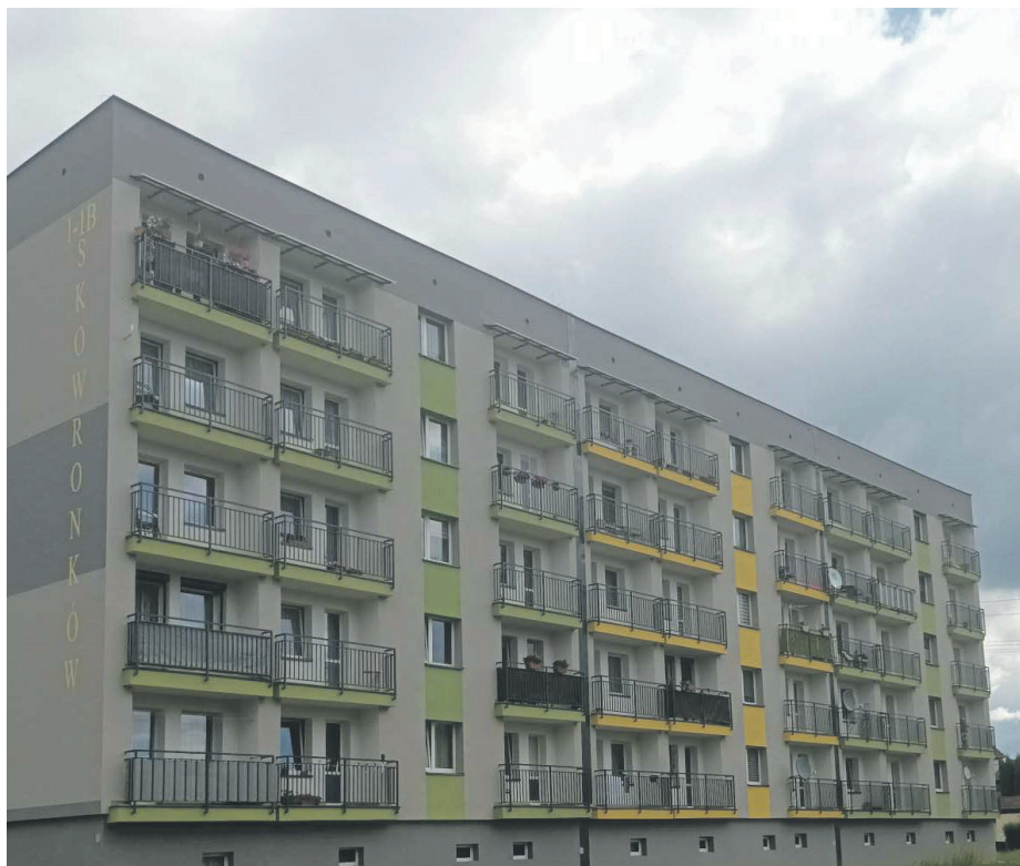
Budynek przy ul. Skowronków 1-1b.
